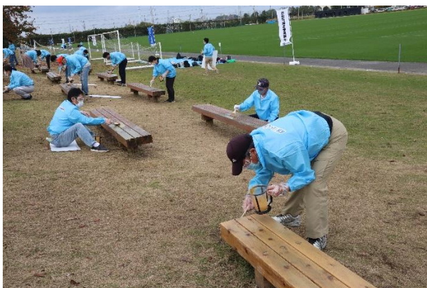
塗装作業風景
