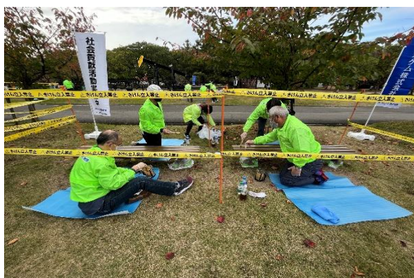
塗装作業風景
