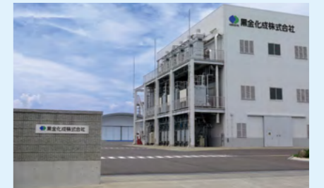
半導体向けプロセス材料に用いられるモノマー、ポリマーの受託製造に高い技術を有する黒金化成
